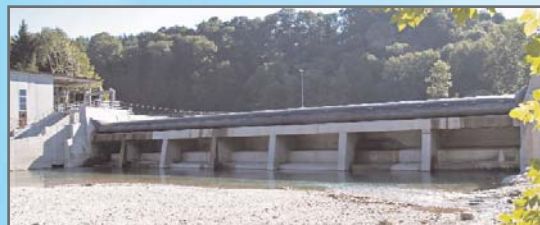
40 Meter Länge misst die Schlauchwehr von Hydroconstruct
