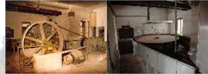
Abbildung: Kraftwerk Scharnstein im Jahr 1979 und heute
