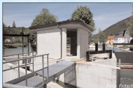
Krafthaus des KW Geyerwehr im Bau
