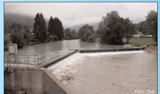
Zweiteilige Hydroconstruct-Schlauchwehr in Scharstein
